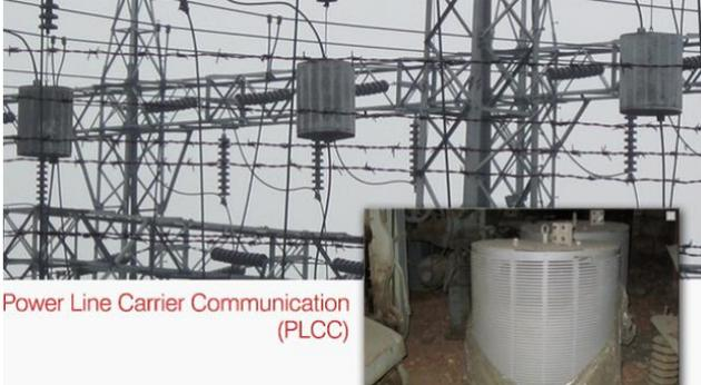
الاتصالات عبر خط الكهرباء (PLC) Power Line Carrier هو نظام لنقل البيانات على الموصلات التي تستخدم أيضا لنقل الطاقة الكهربائية. وهي المعروفة أيضا باسم قوة الخط الناقل وخط كهرباء المشترك الرقمي (PDSL)، واتصالات الأنايبب، خط الاتصالات الكهربائي (PLT)، و خط كهرباء الشبكات (PLN)، والنطاق العريض عبر خطوط الطاقة (BPL).
