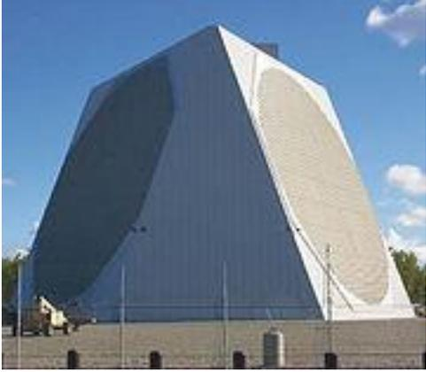
لا يختلف رادار المصفوفة الطورية عن الرادار التقليدي سوى في نوع الهوائي المستخدم والطريقة التي يتم بها مسح الفضاء بشعاع الهوائي. ففي الرادار التقليدي تستخدم الهوائيات الصحنية والتي يتم تدويرها بسرعة معينة لكي تتم عملية المسح بينما يستخدم رادار المصفوفة الطورية هوائيات ثابتة لا تتحرك وتتم عملية مسح الفضاء المحيط بتوجيه الشعاع وتحريكه بطريقة إلكترونية. ويكمن سر هذا الرادار في هوائي المصفوفة الطورية ( phased array antenna) وهو عبارة عن مجموعة من الهوائيات البسيطة (dipole antennas) يتم تغذيتها
